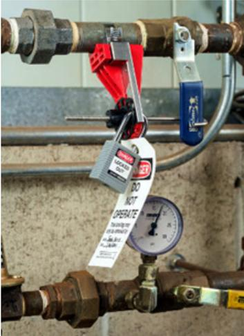
En la actualidad se utilizan energías peligrosas para la fabricación de muchos productos. En el momento en el cual la maquinaria o el proceso requiere de un mantenimiento ya sea preventivo o correctivo es indispensable controlar estas energías para realizarlo en forma segura y así mantener la integridad y la salud de los trabajadores que intervienen.
